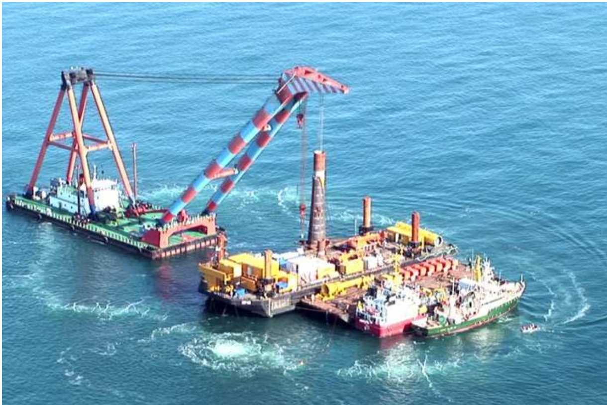
Bild 6.4: Blasenschleier im Testbetrieb (Schwimmkran Samson, Hubinsel mit aufgerichtetem Pfahl in der Rammführung, Seeponton mit Dieselkompressoren, Ölbekämpfungsschiff, Verkehrssicherungsschiff).
